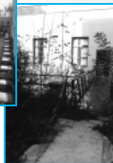
Stato di degrado a via Lepanto Foto di Simona Foschi
