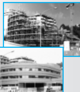
In pochi mesi sono stati realizzati i nuovi uffici di Piazzale Clodio della Corte di Appello Foto di Simona Foschi
