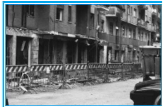
I locali distrutti dall'esplosione visti dall'interno di Via Ventotene Foto di Simona Foschi
